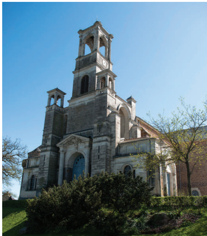
L'église paroissiale de Montfort-sur-Meu, d'abord dédiée à saint Jean-Baptiste, puis à saint Louis-Marie Grignon de Montfort
